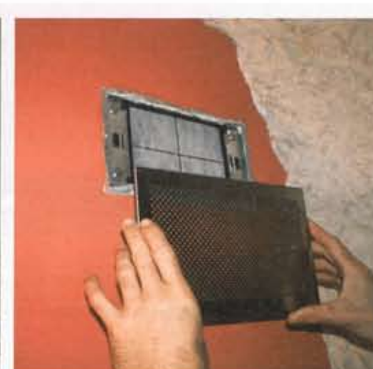
► Dans chaque pièce, les entrées d'air sont dotées de filtres. Aux entrées d'air de la machine, les particules sont filtrées. La prise d'air extérieur est munie d'un filtre pour les grosses particules. Tous doivent être régulièrement nettoyés. La régulation intègre une alerte sur les pertes de charge.
