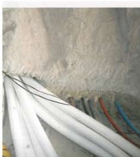
► Chaque pièce est dotée d'une arrivée et d'une sortie d'air. Cela nécessite la réalisation ventuelle de gaines techniques et/ou le percement des murs. Ici il a fallu percer des trous en pierre (tuffeau) de plus de 50 cm d'épaisseur.
